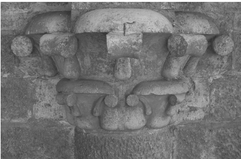
6. Lilienkapitell des Grabbaus GB 14 an der Nordfassade (Phot. K. Lembke).
