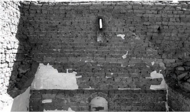
Abb. 4: Gewölbetyp 1: Ringschichtentonnengewölbe, Zustand: 2010 (Aufnahme: Wilkening-Aumann).
